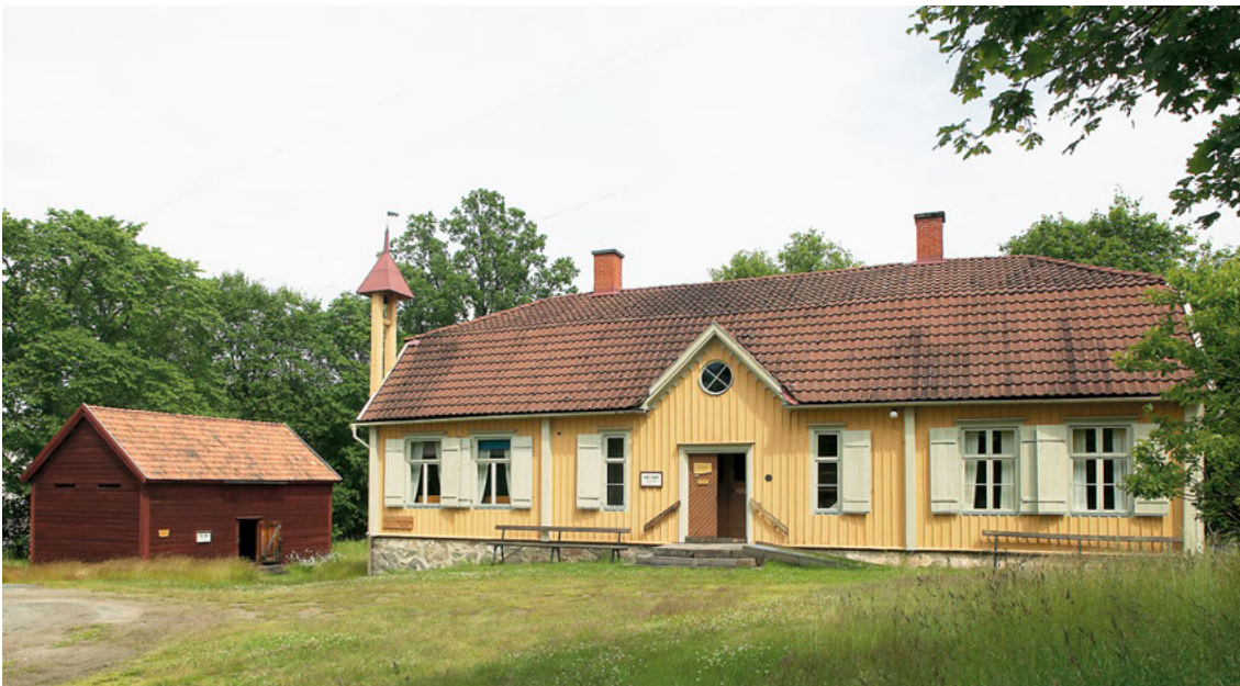
FIGUR 5. Ishult tingshus i Tunalands härad. Tingsplats flyttades från Krokstorp till byn Ishult 1729. Byggnaden fick sitt nuvarande utseende efter en brand strax före 1820 samt vid en om- och tillbyggnad 1917. Trots något senare tillkomst och senare ändringar kan byggnaden anses vara ett typiskt exempel på publika byggnader som uppfördes enligt 1776 års förordning om publikt byggande. Ishults by är ett bygdecentrum med äldre träbebyggelse: tingshus, häkte, stallar, tingsklocka och gästgivaregård. Till tingsplatsen leder en av alléer kantad gammal väg på Tunaåsen. Ishult fungerade som tingsplats fram till 1935. Foto Bengt A. Lundberg, Riksantikvarieämbetet.
